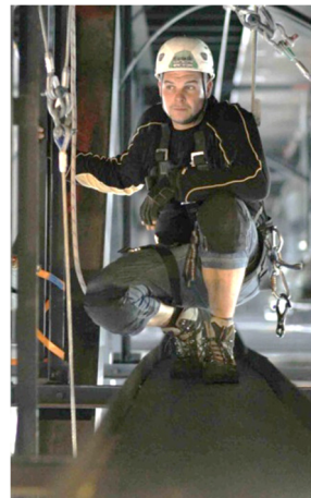
5 Rigger correctement équipé sur le lieu de travail.
